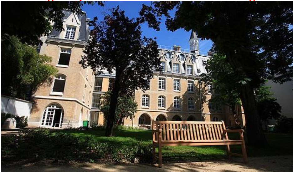
Siège de la CEF avenue de Breteuil depuis 2004 (acheté à la congrégation des sœurs Notre-Dame du Cénacle)
