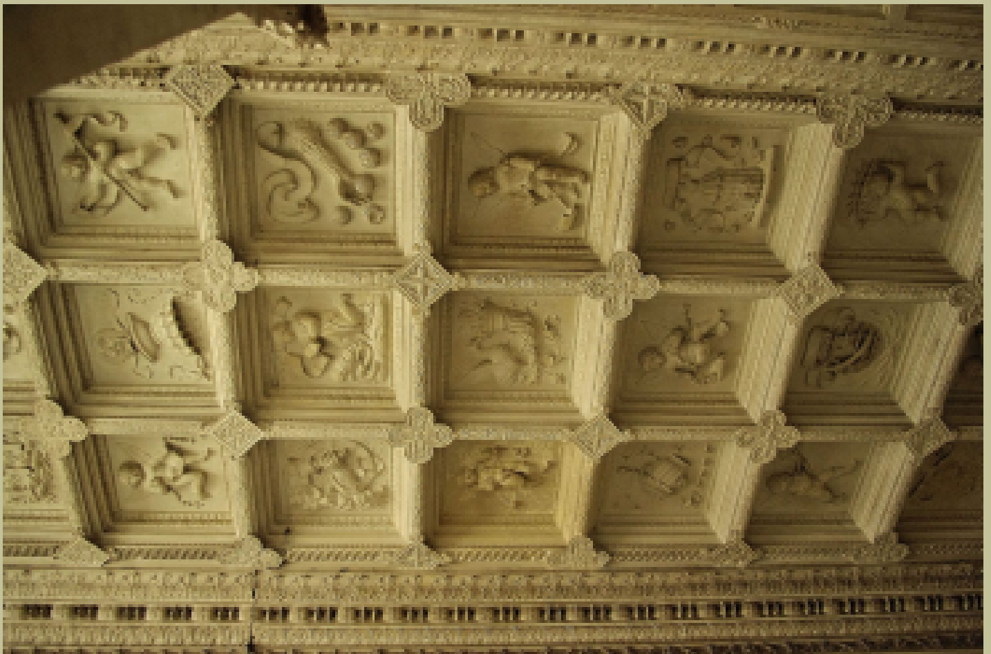
Plafond à caissons de l'Hôtel Lallemant
