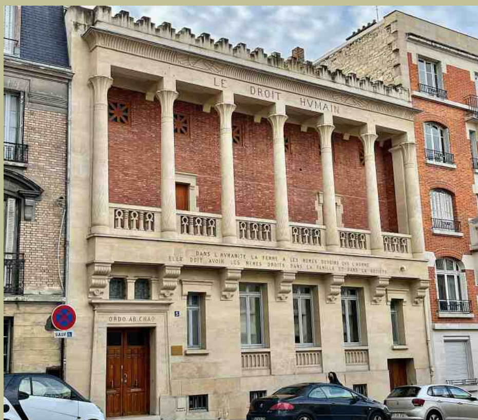
La façade des locaux du Droit Humain international rue Jules Breton
